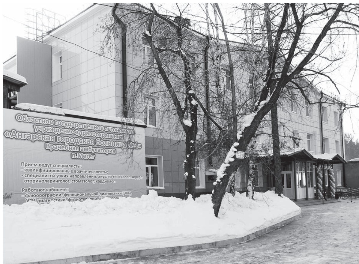
Здание поликлиники в Мегете было отдано под реконструкцию в 2009 году, но тогда процесс был остановлен. Возобновилась стройка только через восемь лет, в 2017 году. Открытие праздновали всем посёлком.
