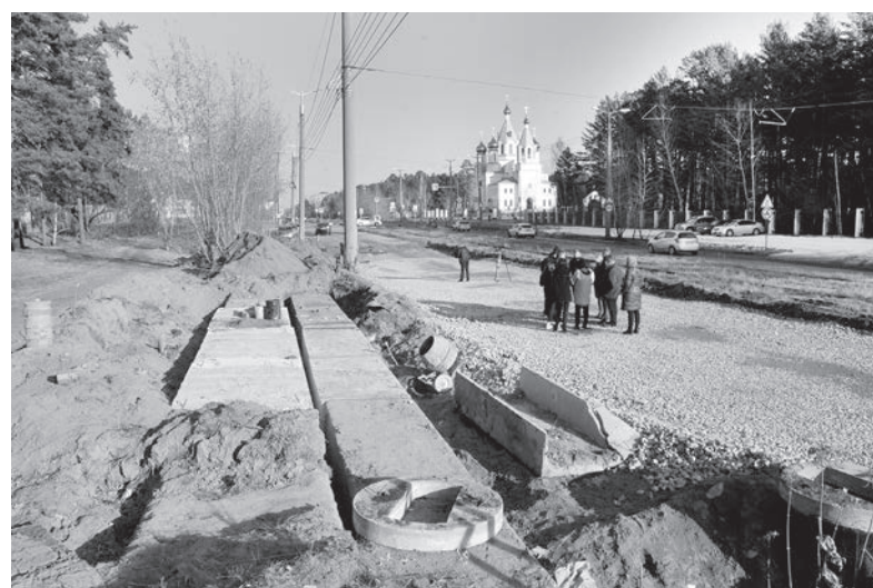
Вынужденный перенос труб отнял у строителей второй полосы Чайковского почти 2,5 месяца драгоценного времени в тёплый сезон
