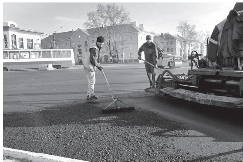
Благодаря участию в проекте «Безопасные и качественные автомобильные дороги» на пересечении улиц Олега Кошевого и Иркутской удалось заменить не только покрытие, но и рельсы
