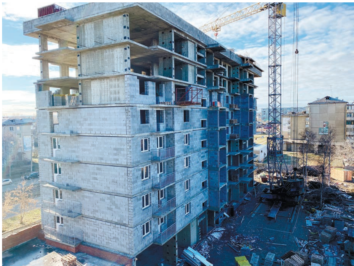
Жилой комплекс «Современник» строится с опережением графика
