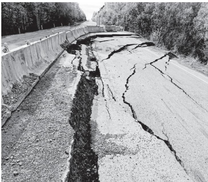
Разрушения на трассе «Байкал» возле села Клюевка. Причина возникновения оползня - обильные затяжные ливни, которые вызвали гидрогеологические изменения. Землетрясение усугубило процесс. Величина просадки грунта составила полтора метра
