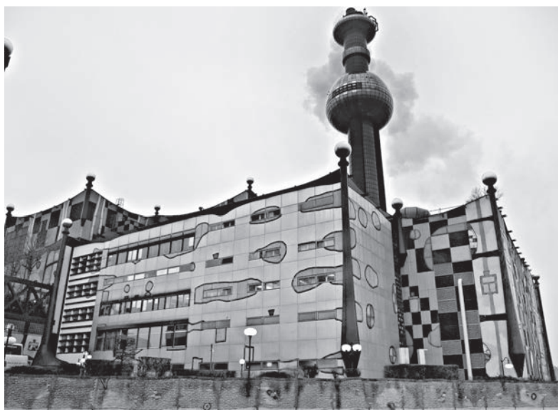
Вот так выглядит завод по переработке мусора в Вене. Он разместился в самом центре столицы Австрии, его необычный архитектурный стиль привлекает большое количество туристов. Здание не выпускает ни молекул вредных газов. Это престижный район, потому что тепло от переработки мусора отапливает дома в нём абсолютно бесплатно
