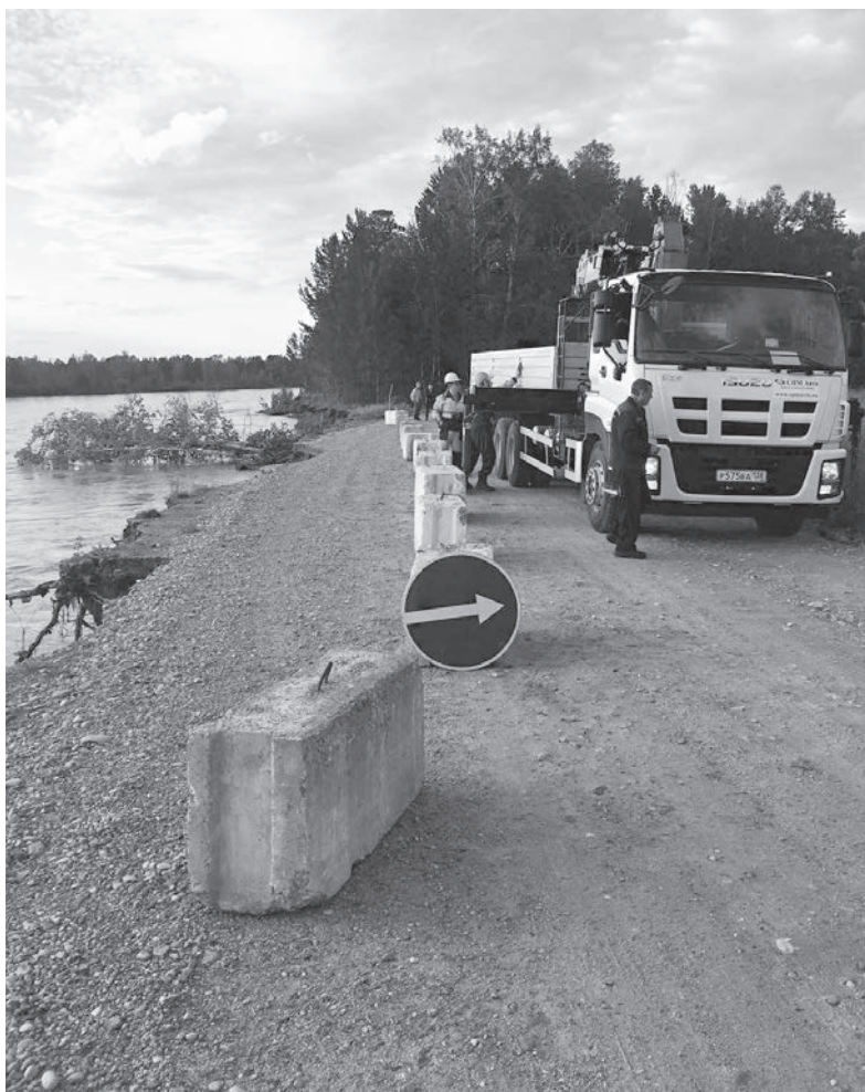
Ради безопасности автомобилистов специалисты выставили блоки вдоль дороги - вода съела приличную часть берега, превратив его в неглубокий, но крутой обрыв
