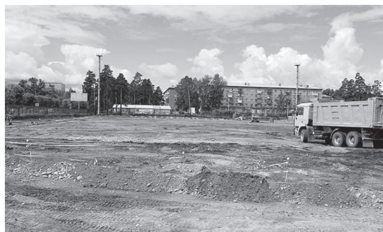
Также в сентябре должен завершиться капремонт спортплощадки в школе «Сибиряк». Здесь появится футбольное поле, баскетбольная площадка, беговые дорожки, трибуны
