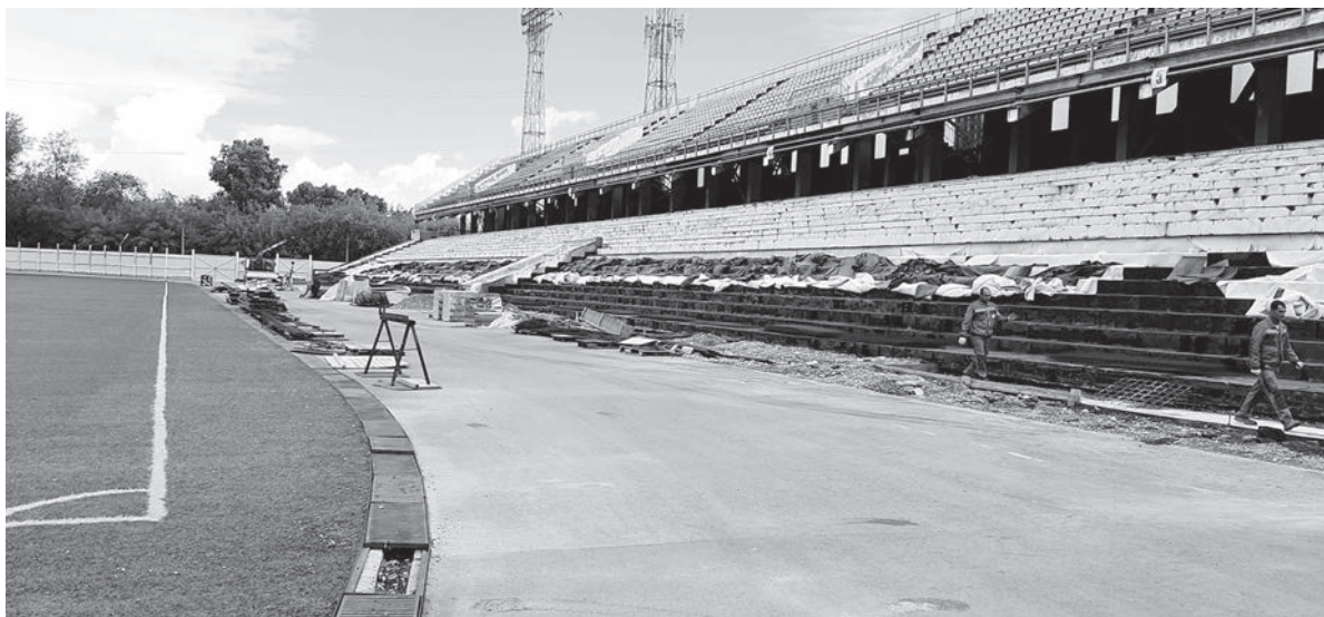
Масштабные работы ведутся на стадионе «Ангара». Здесь ремонтируют восточную трибуну
