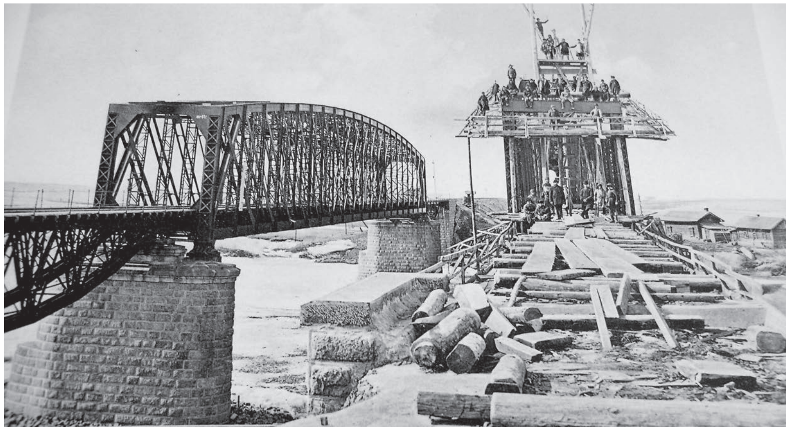
3021 Верста. Сборка 40 сажень фермы нового моста через р. Китой. Металлические конструкции работы Сормовского завода. Зима 1910-1911 года
