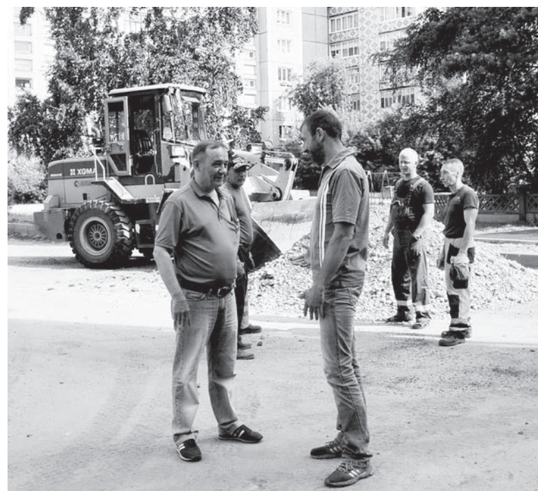
Сегодня на округе депутата Куранова полным ходом идёт благоустройство территории, прилегающей к дому 13 в 19 микрорайоне
