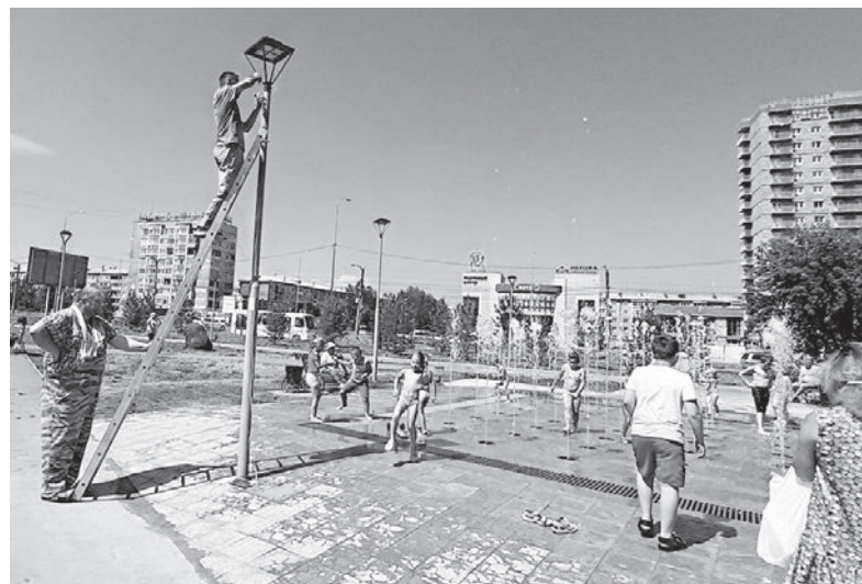
Около фонтана установили датчик ветра, который будет контролировать силу подачи воды
