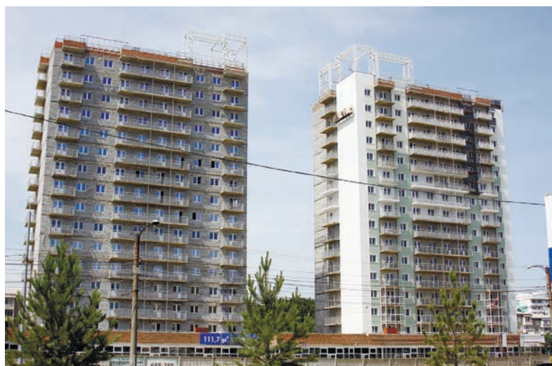
Автоклавный газобетон ангарского производства используется при строительстве многоквартирных домов по всей Сибири и на Дальнем Востоке
