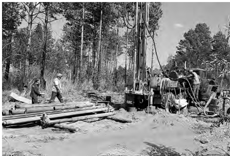
25 мая 2020 года. Первый Нижнекитойский участок месторождения пресных подземных вод. Буровых дел мастера пробивают скважины, которые станут частью собственного закрытого источника питьевой воды, расположенного на Китойском месторождении
