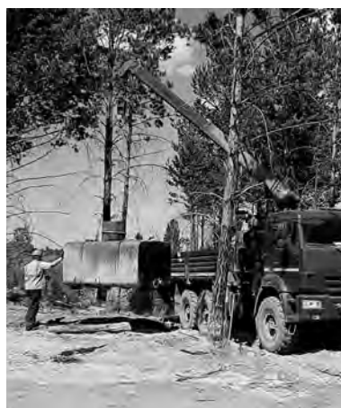
Здесь на строительной площадке - жара и клещи. Но это не мешает готовиться к возведению будущего водозабора
