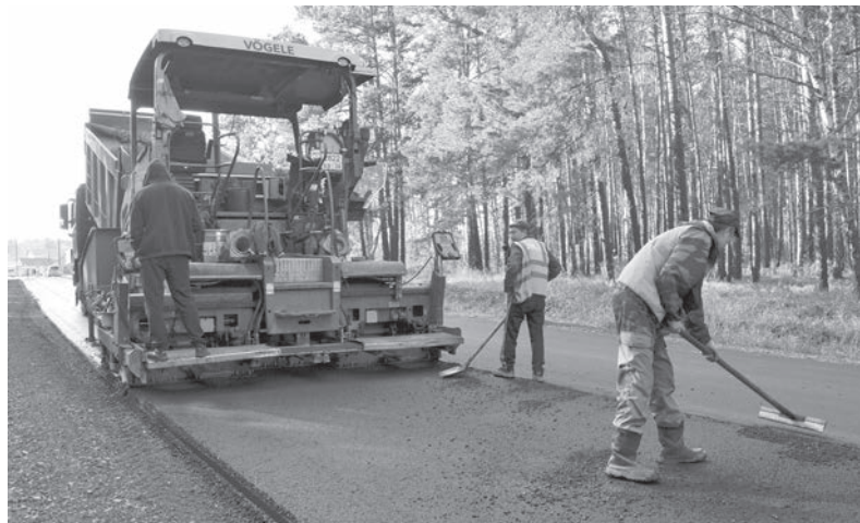
В 2019 году было отремонтировано восемь улиц. Это свыше 316 тысяч квадратных метров дорожного полотна
