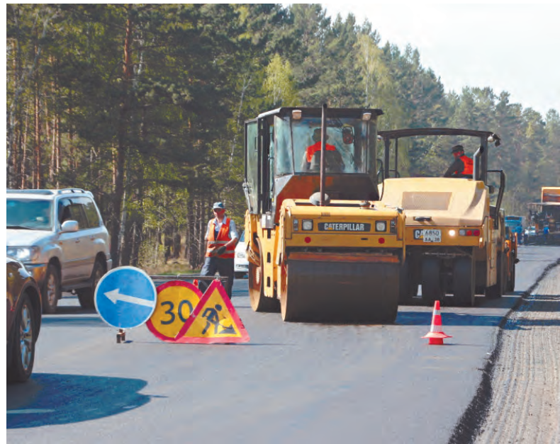
Почти все муниципальные контракты на проведение ремонтных работ уже заключены
