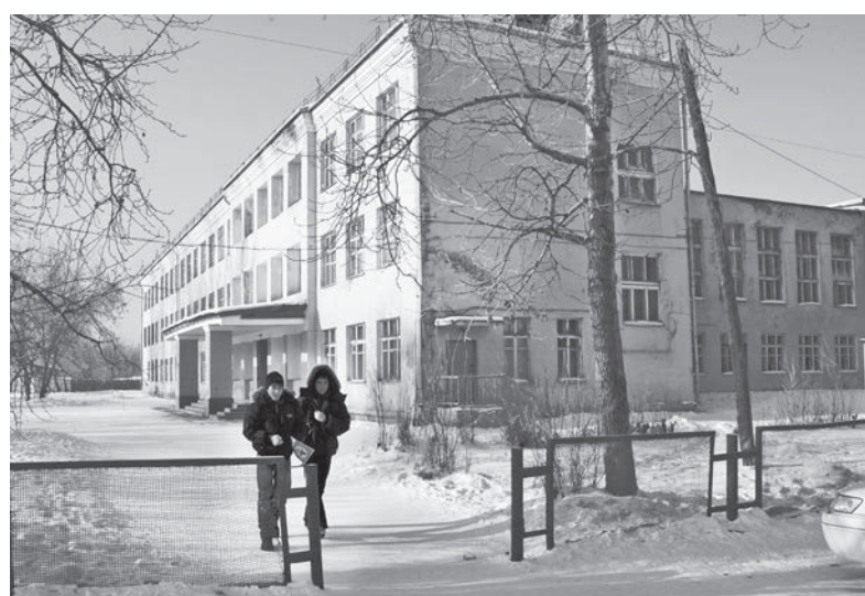
Мегетская школа поэтапно ремонтируется, но основная задача - строительство здесь новой школы, проект которой сегодня разрабатывается. А проект детской школы искусств, которая будет совмещена с культурно-досуговым центром, уже готов. В этом году будет проведена экспертиза проектной документации, в следующем планируется начать строительство
