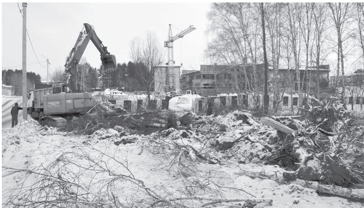
В необходимости детского сада в 22 микрорайоне нет сомнений. Для его функционирования нужны инженерные сети, которые невозможно было проложить без вырубki деревьев
