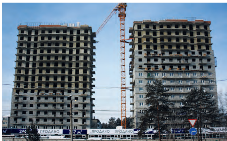
Строительство 16-этажного ЖК «Рассвет»
