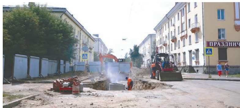
Темпы работы в этом году были высокими: необходимо было переложить около 15 км труб - ржавые трубы меняли на современные, долговечные полиэтиленовые
