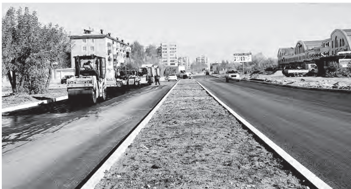
В этом году по партийному проекту «Безопасные и качественные автомобильные дороги» был в том числе проведён капремонт участка улицы Декабристов протяжённостью 1200 метров. За счёт устройства дополнительных полос движения проезжая площадь здесь расширена на 13 метров
