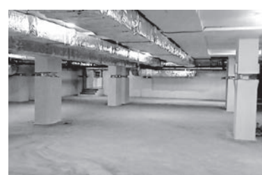
Под пятью блоками школы расположены специальные опоры. Они позволят зданию раскачиваться, но не разрушаться даже при 9-балльном землетрясении
