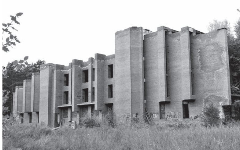
Важно знать, что, когда стройку забросили, никто не подумал о консервации объекта
