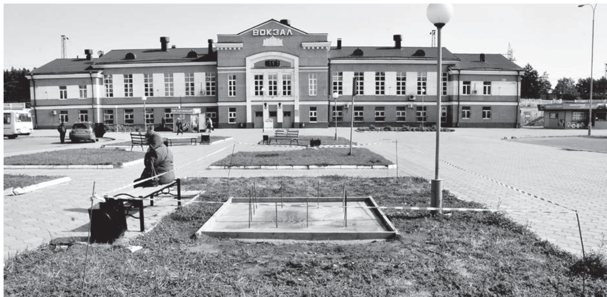
На привокзальной площади уже залито основание для памятника
