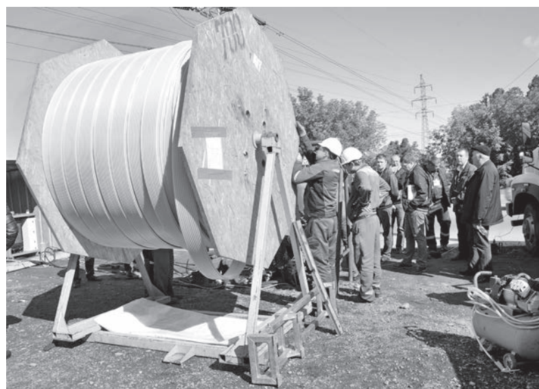
Всего технологией спиральной навивки в городе будет заменено около 500 метров трубопровода
