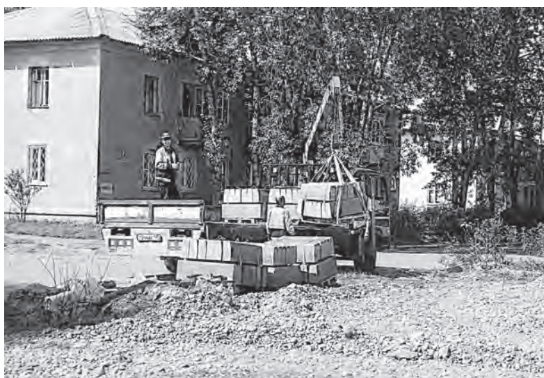
В настоящее время завезён бордюрный камень и строители готовы приступить к обустройству дорожек
