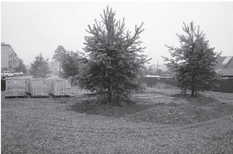
Как только погода позволит, строители приступят к подготовительным работам для укладки плитки
