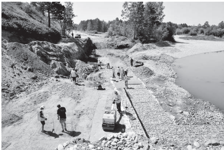
Прибрежная территория больше напоминает строительную площадку. Повсюду, как муравьи, снуют рабочие
