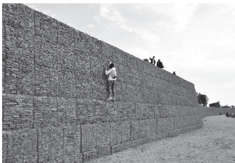
Каменные панно высотой в несколько метров - это прежде всего элемент не красоты, а часть технического сооружения. Габионы не позволяют берегу осыпаться
