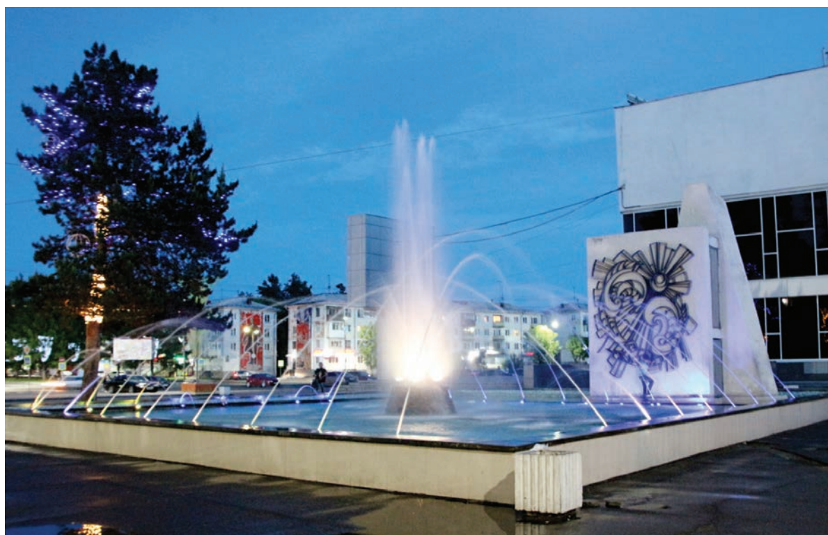
В парке ДК «Современник» требовала большого ремонта чаша фонтана. Здесь провели замену гидроизоляции, облицовку наружных стен керамогранитом, облицовку днища фонтана керамической плиткой, с устройством светодиодной подсветки. Кроме того, был проведён ремонт элементов конструкций фонтана, замена форсунок и центральной насадки
