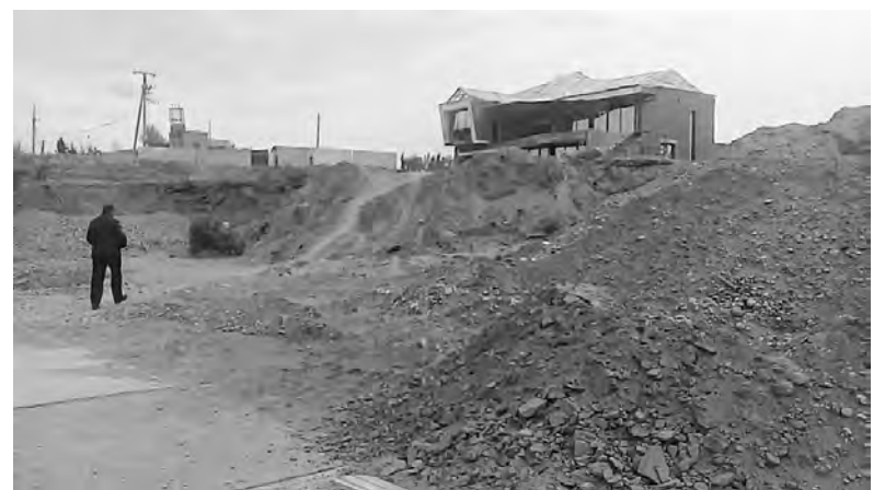
Пока нам приходится идти по гравийной дороге от пешеходного бульвара к самой набережной. Завтра же ангарчане смогут комфортно спускаться по обустроенному парадному входу
