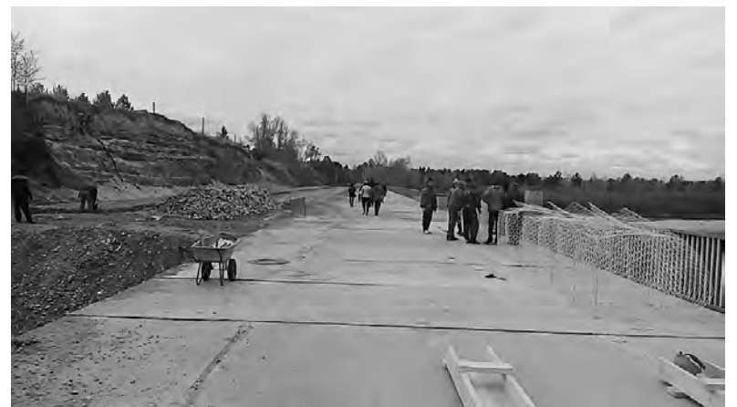
Подрядчику предстоит провести земляные работы, подготовить основание под асфальт и выставить габионы
