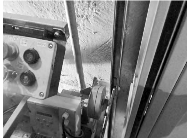
А вот пример «качественной» работы подрядчика областного Фонда капремонта - короб для кабелей закреплён так, что двери кабины лифта полностью не открываются
