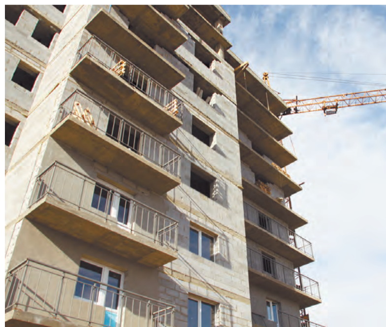
Практически все дома в Ангарске строятся из прочного и надёжного автоклавного газобетона
