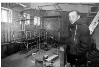
Ремонт бассейна в школе №9
