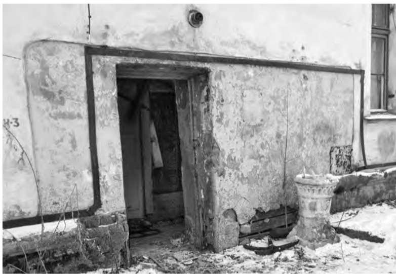
Здание больше напоминает дом после бомбёжки - всё, что можно было снять и сдать в пункт по приёму металла, варварски вырвали, не очень беспокоясь о состоянии фасада
