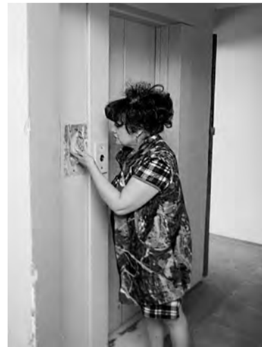
Уже полгода жильцы дома 39 «любуются» шахтой лифта через дыры, оставленные рабочими на месте прежних панелей вызова
