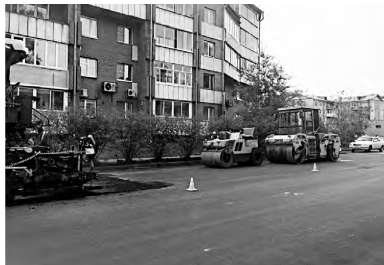
На улице 40 лет Октября нижний слой покрытия уложен, пробы лаборатории взяла, выдала положительное заключение
