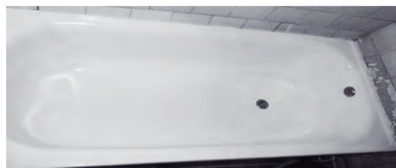
После установки акрилового вкладыша в ванну
