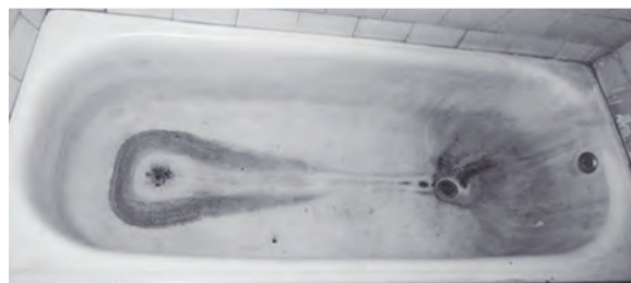
До установки акрилового вкладыша в ванну
