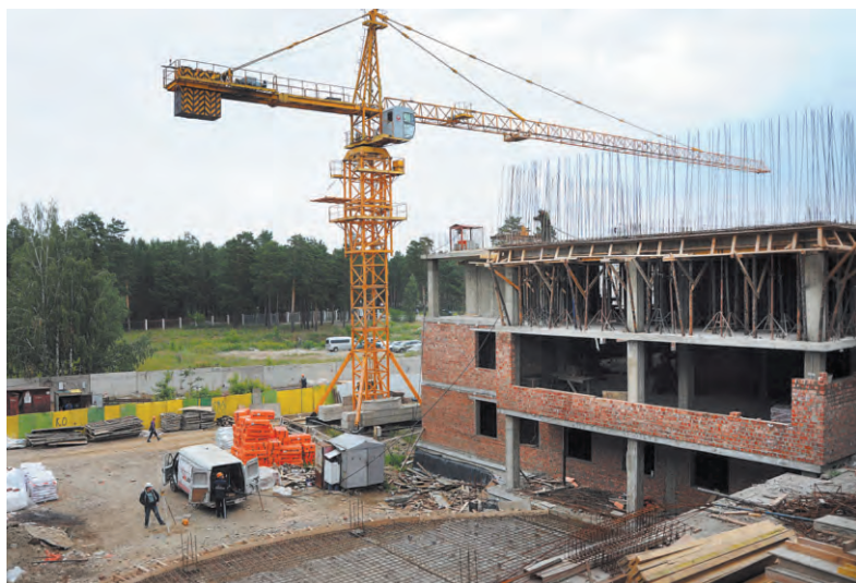
Сейчас на стройке снова кипит работа. Трёхлетний контракт на окончательное строительство школы был заключён в 2017 году
