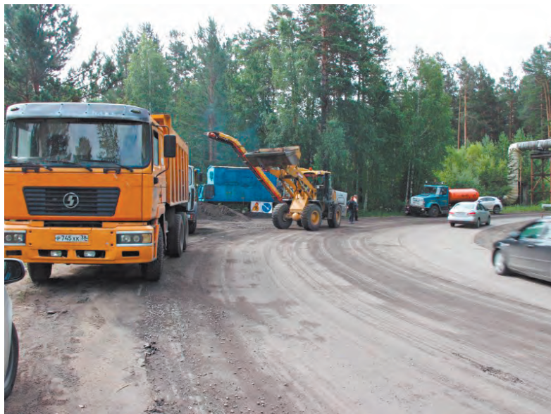
В целом в 2018 году в округе будет отремонтировано 20 км дорог
