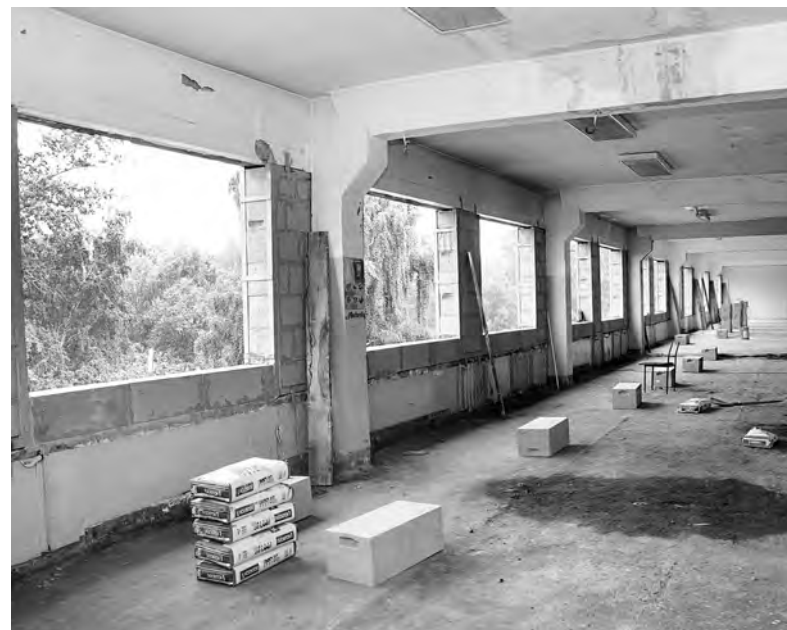
От прежнего здания только коробка, всё остальное выстраивают заново. Демонтированы старые окна и двери, убраны перегородки
