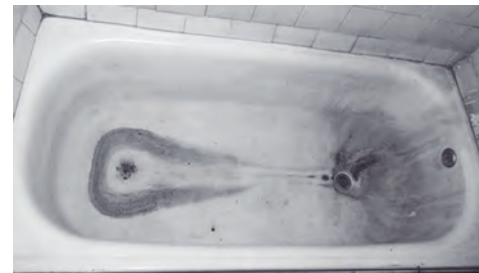
До установки акрилового вкладыша в ванну
