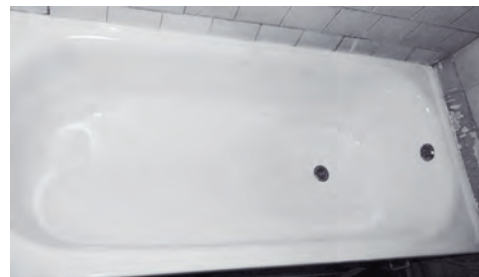
После установки акрилового вкладыша в ванну
