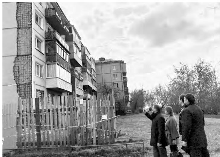
После обрушения части фактурного слоя было принято решение произвести контролируемое обрушение остальной части треснувшей облицовки. Далее будут организованы гидроизоляционные работы, чтобы предотвратить попадание влаги
