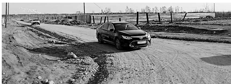
В прошлом году были отсыпаны подъездные пути к участкам в 256 квартале. Кроме того, до 256 квартала был проведён водопровод за счёт местного бюджета. На выезде из квартала установлена цифровая водоколонка
