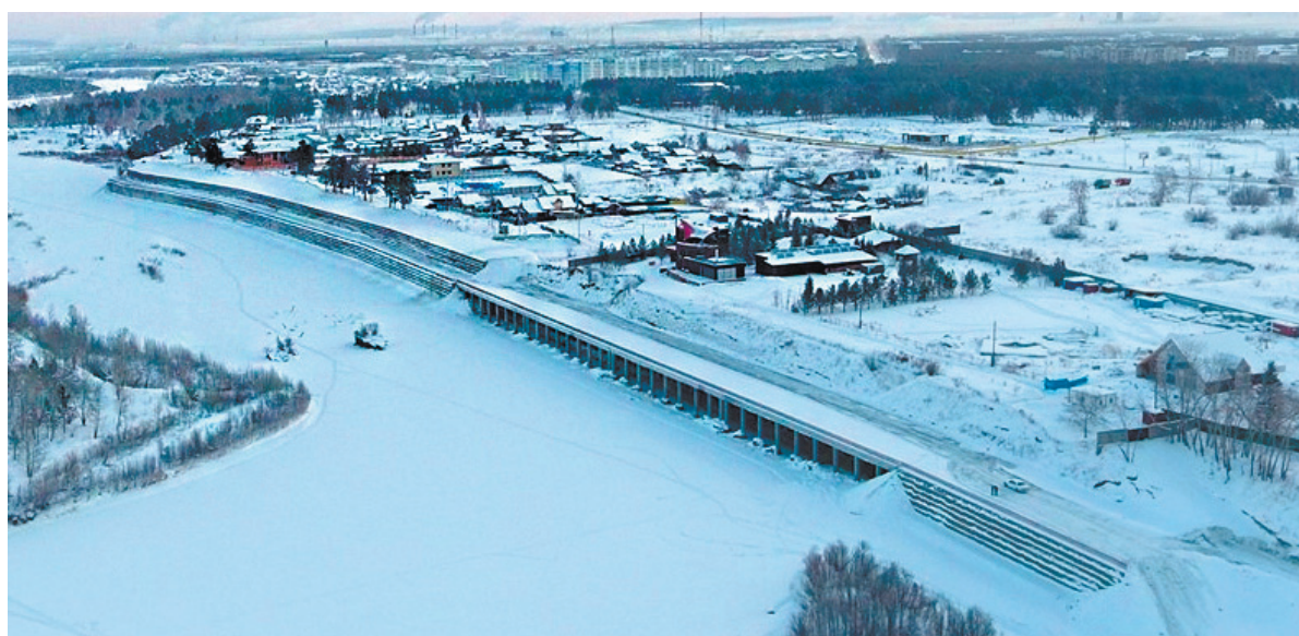
На фото: завершён первый этап строительства набережной - берегоукрепление реки Китой. Наибольшее количество предложений ангарчан поступило именно на её благоустройство. В лидерах также оказались сквер в микрорайоне Цементном и Сталинградская аллея в 7 микрорайоне. Именно эти три территории будут представлены на открытом голосовании
