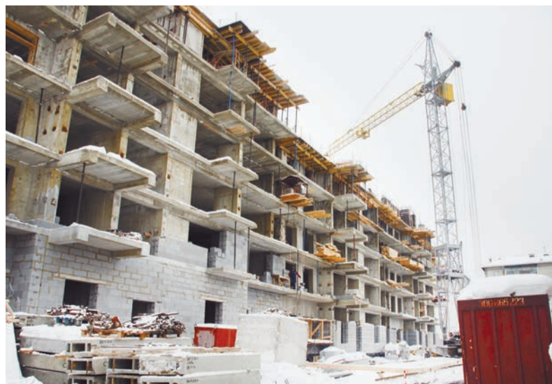
В разгаре строительство ЖК «Весна» в 29 микрорайоне
