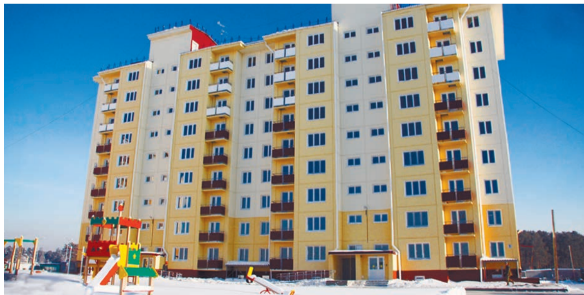
1-я и 2-я блок-секции домов на ул. Радужной сданы. Началось строительство 3-й блок-секции
