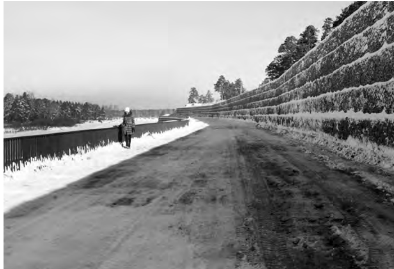
С одной стороны - заснеженный Китой, с другой - высокая подпорная стена из габионов. Пробраз будущей набережной - мечты нескольких поколений ангарчан - готов
