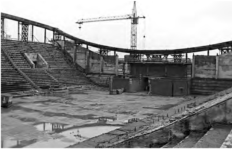
2003 год. Начало реконструкции стадиона
