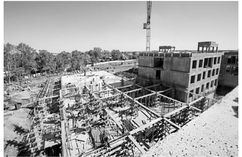
По проекту школа должна быть построена в 2019 году, но подрядчик планирует завершить строительство в 2018 году
