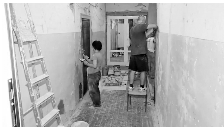
В эти дни обновляется внутренний и внешний вид здания
