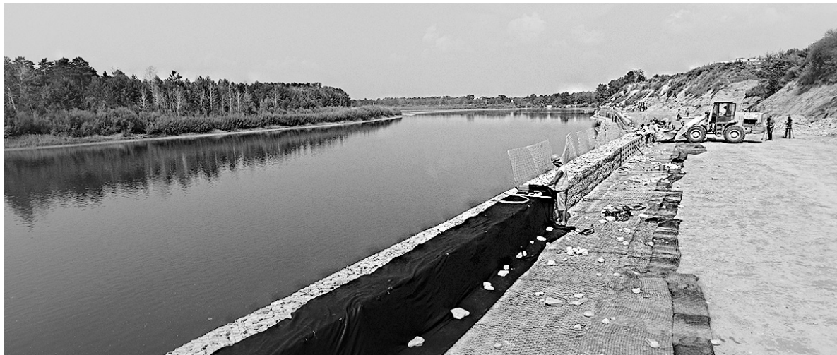
На месте будущей набережной с размахом продолжаются работы по берегоукреплению Китою
