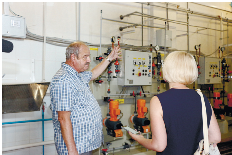
Перед подачей потребителям вода проходит несколько уровней водоочистки для улучшения органолептических (мутности, цветности) и микробиологических показателей
