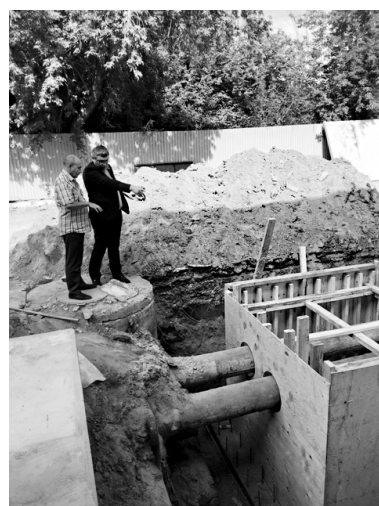
Депутат Дмитрий Ершов в очередной раз проверил, как идёт ремонт на важной для мегетчан стройке
