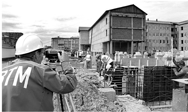
Сегодня на фундамент устанавливают резинометаллические компенсаторы, а уже на них будет расти новое здание клубного блока. Это уникальная технология, эдакие подушки, которые устанавливают на каждую несущую колонну
