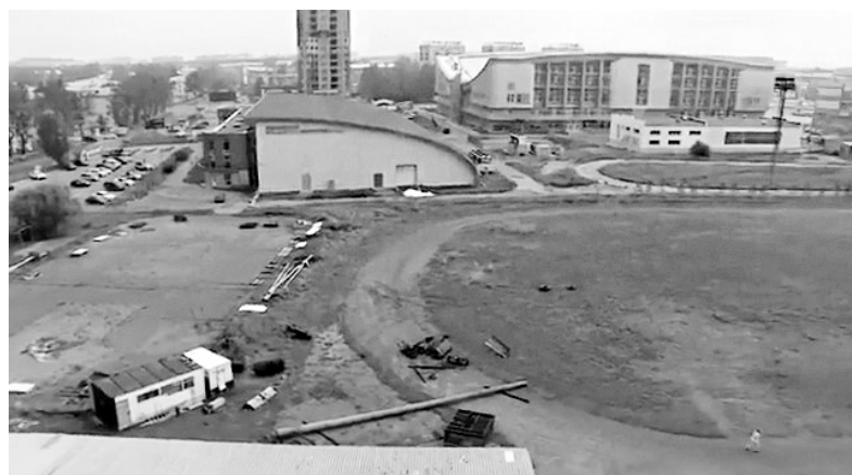
На стадионе в 192 квартале полным ходом идут работы по демонтажу старых конструкций
