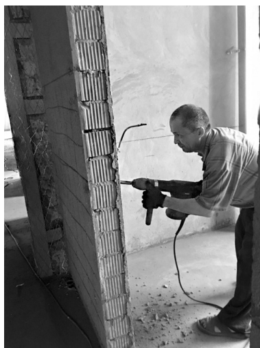
Работы в здании будущей мегетской поликлиники кипят с утра до позднего вечера
