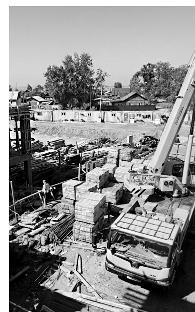
12 часов в сутки на площадке кипит работа
