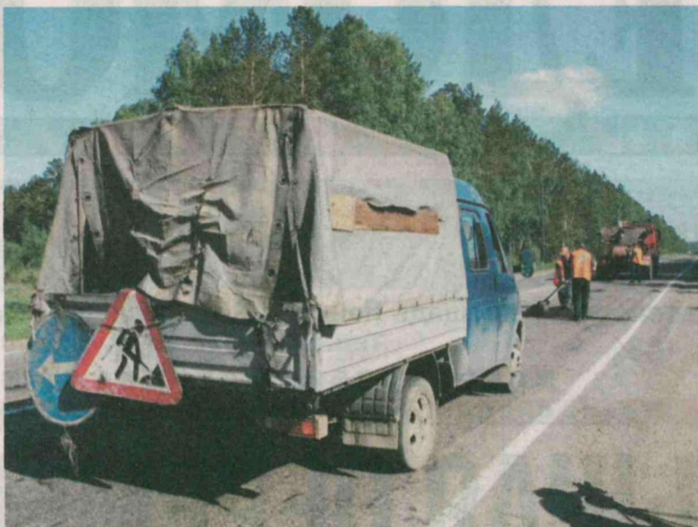
В этом году ямочный ремонт дорожного полотна начат в максимально ранний период - подрядчик приступил к работе в конце марта
