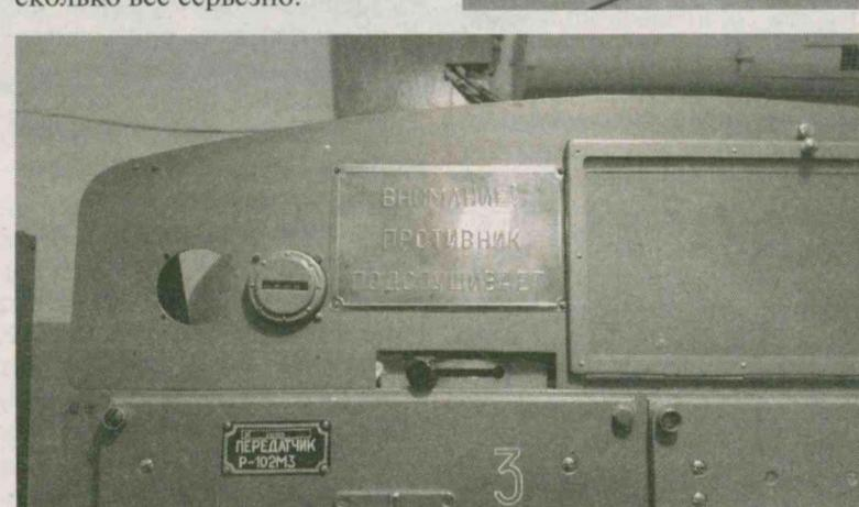
Поскольку мобильная связь под землёй и тем более за глухими стальными дверьми невозможна, в убежище проведена автономная телефонная линия, а в самом штабе бункера установлена радиостанция. Обратите внимание на слова, написанные на передатчике
