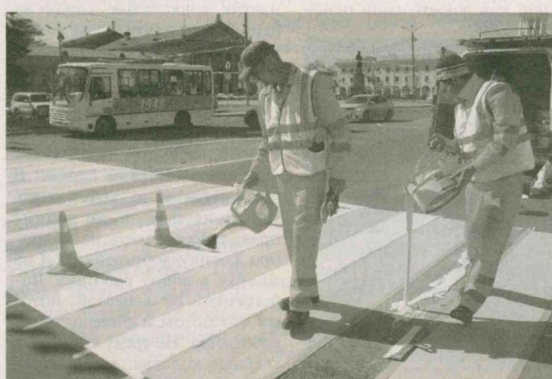
Холодный пластик, которым наносится пешеходный переход, обладает повышенной износостойкостью
