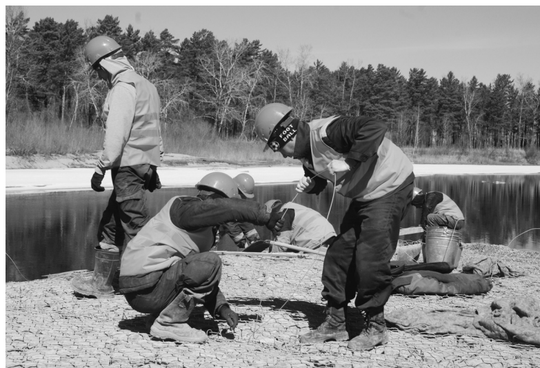
Работники «Сибна» шьют габионные матрасы
