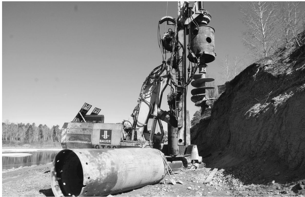
Современная буровая установка проделает в общей сложности 104 скважины для бетонной подпорной стенки
