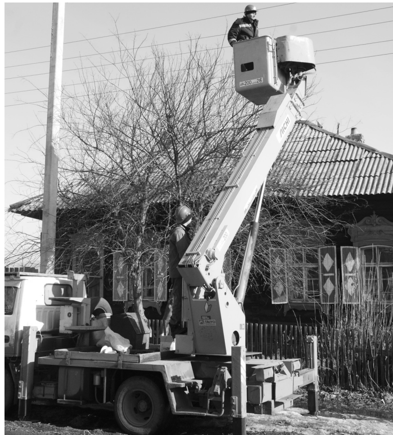
При реконструкции электросетей посёлка Мегет и деревни Зуи был использован современный самонесущий изолированный провод
