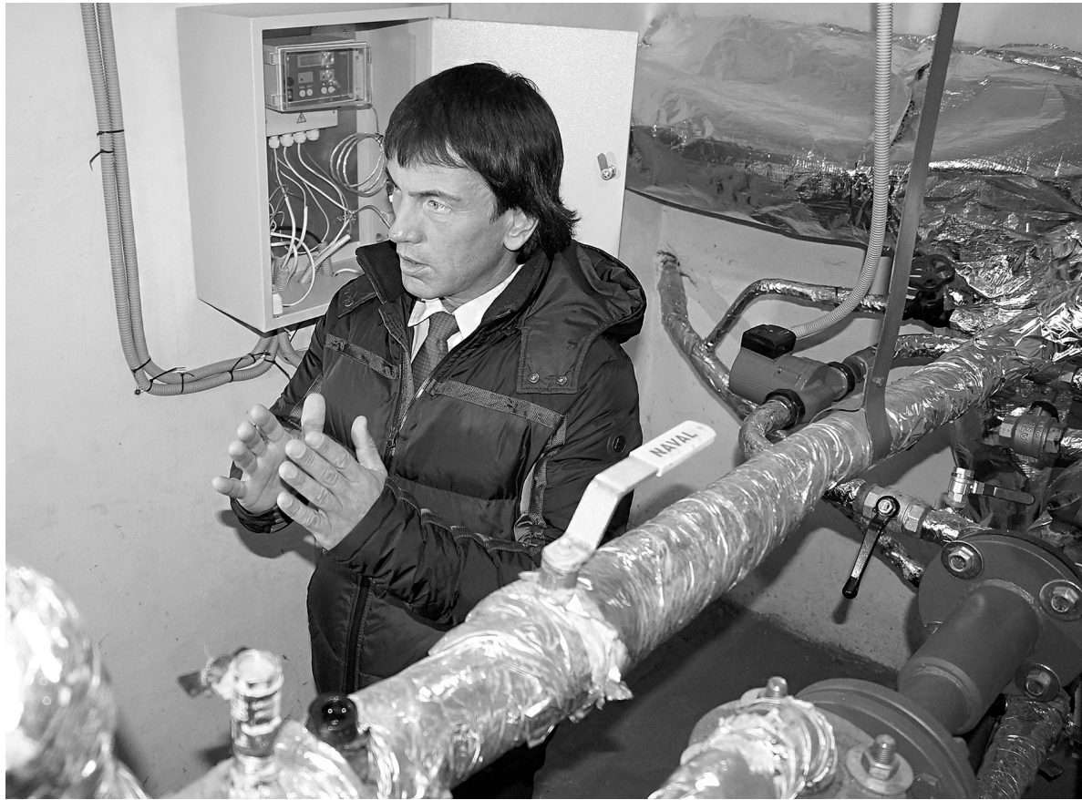
Новое оборудование, установленное по инициативе депутата Сергея ШАРКОВА, позволит на 40 процентов снизить плату за тепло
