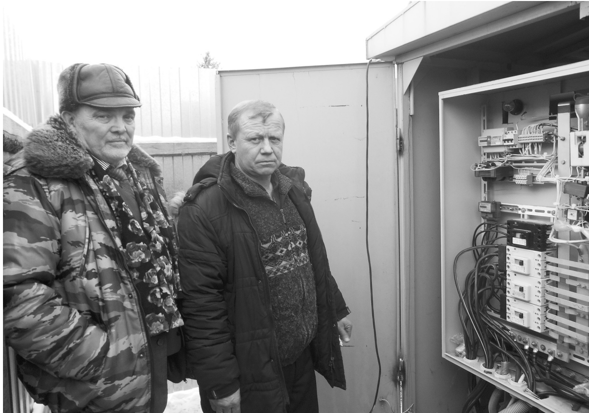
Евгений Марков (справа) показывает, как работает новый трансформатор
