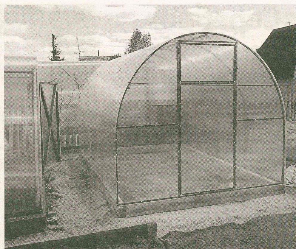
сткости. Для каркаса стандартной шестиметровой теплицы используется семь дуг, установленных на расстоянии 1 метра и скрепленных между собой паз в паз. С нижними направляющими они соединены сваркой, - пояснил он. - Каркас предполагает наличие двух форточек. На все металлические детали нанесено антикоррозийное покрытие.
