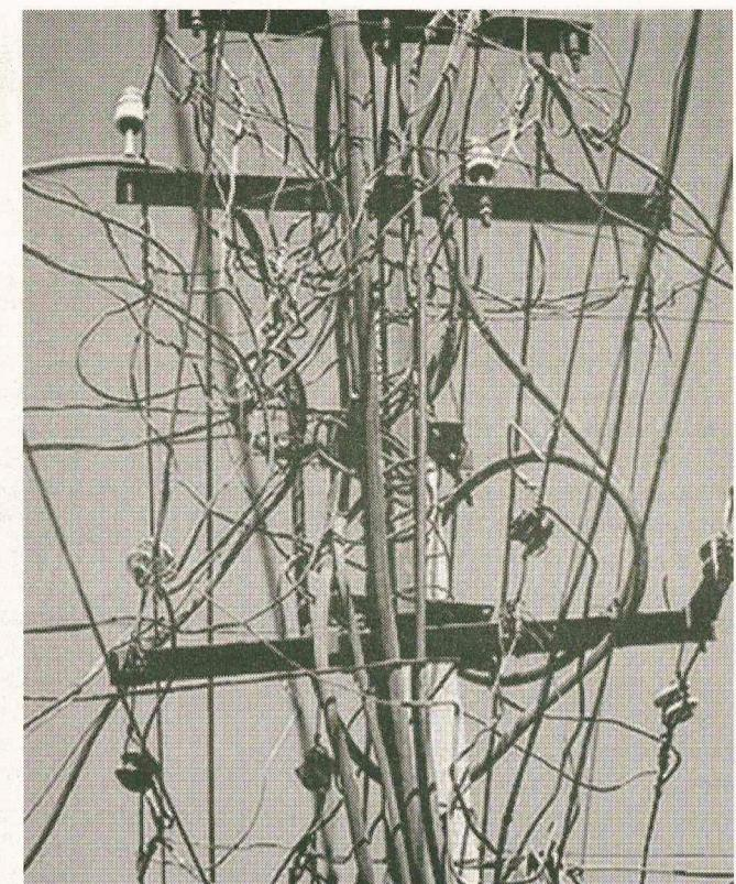
Кабельная линия, которая питает половину Мегета, рассчитана только на уличное освещение, а по ней идет токовая нагрузка, сопоставимая с большим поселком
