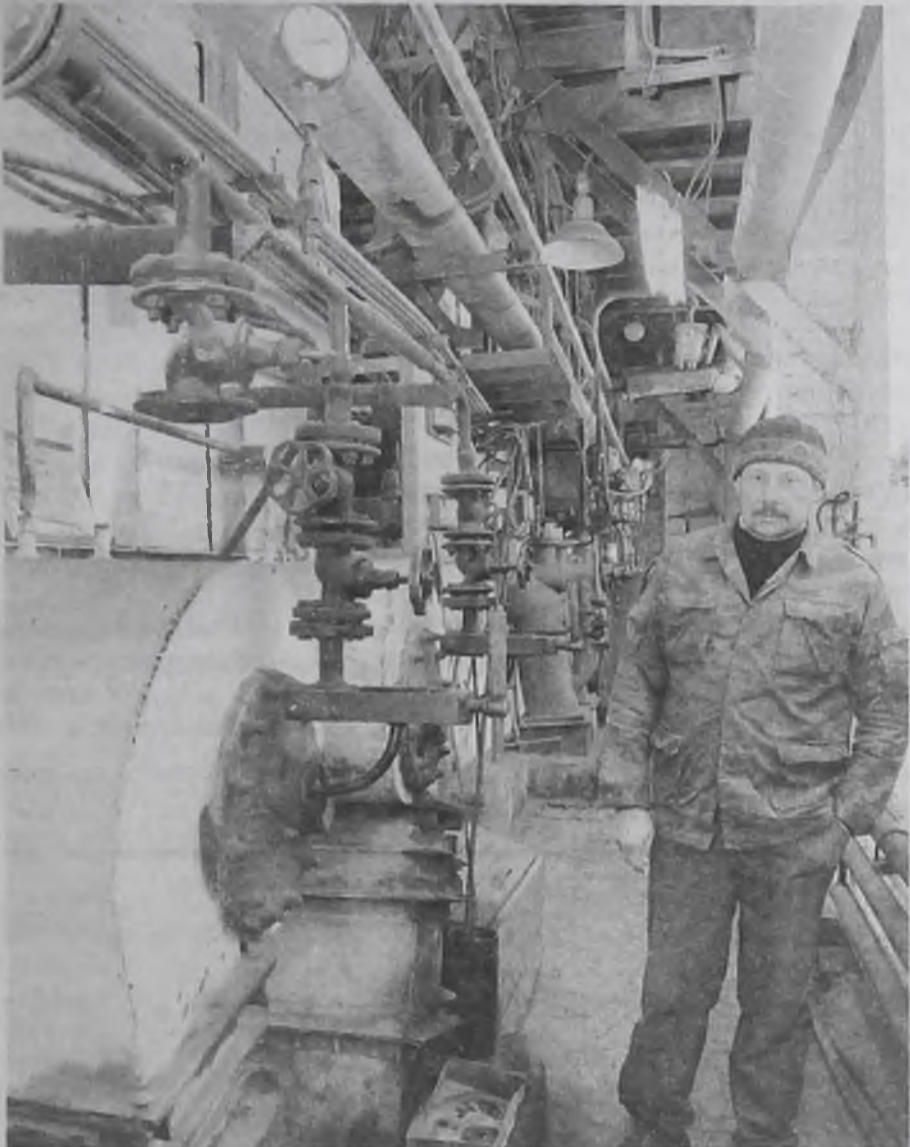
Котельная села Савватеевка. Мощности котлов для обогрева села достаточно
