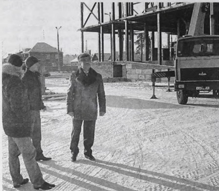
Глава города регулярно осматривает строительные площадки, причем не остается безучастным зрителем, а интересуется, контролирует и проверяет точность и порядок строительства
