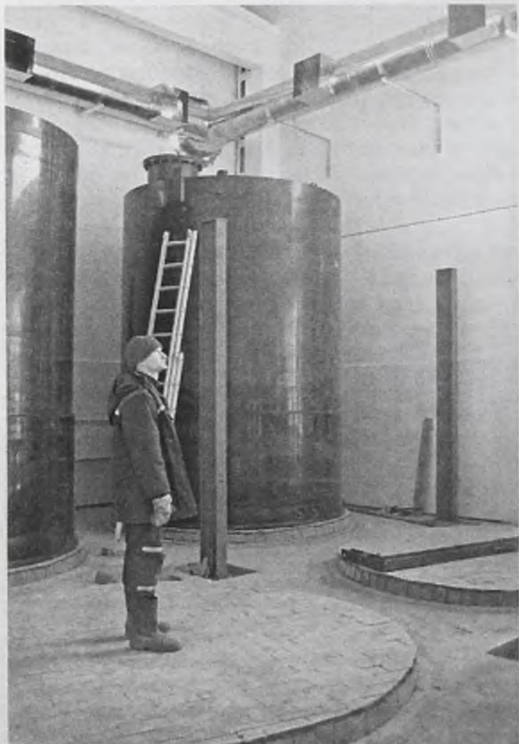
Станцию УФО на «Ангарском Водоканале» открыли. Но тарифы не выросли
