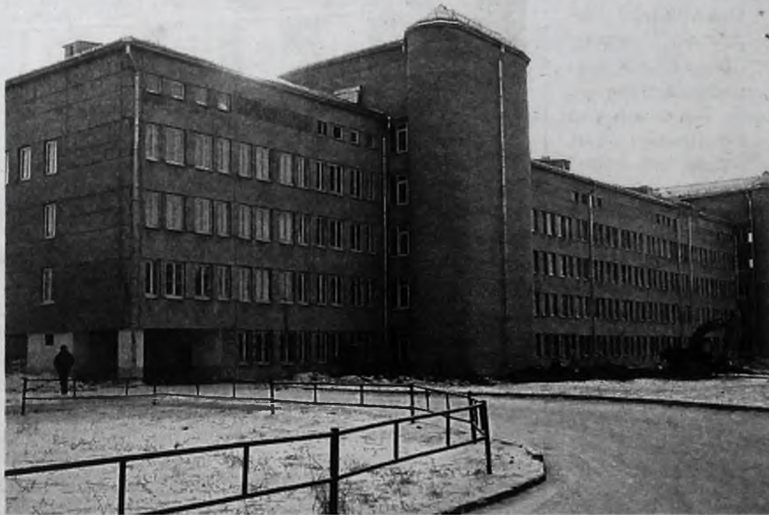
Строительство блока «Г» роддома завершится к середине декабря
