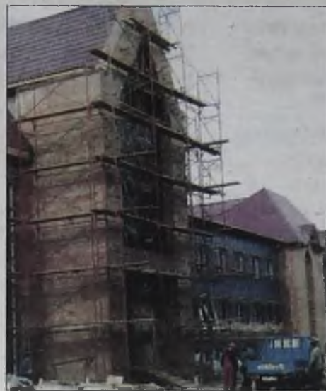
Строящаяся больница в Куйтуне — один из примеров нового подхода к финансированию социальных объектов
