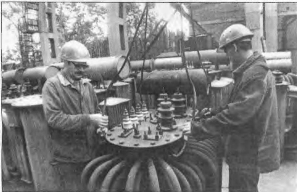
Эти шестикиловольтные трансформаторы привезены для текущего ремонта. Таких в системе электроснабжения СПАО “АУС” более двухсот штук.
